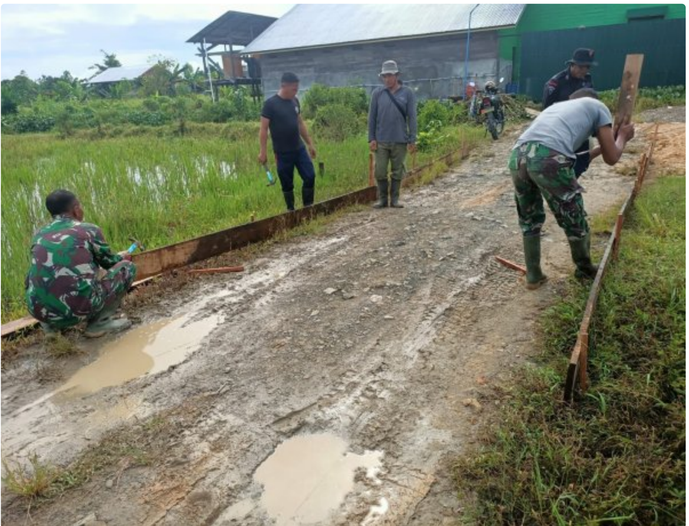
Satgas TMMD 118 Wiltas Kodim 0910/Malinau Persiapkan Semenisasi Jalan dengan Memasang Mal
