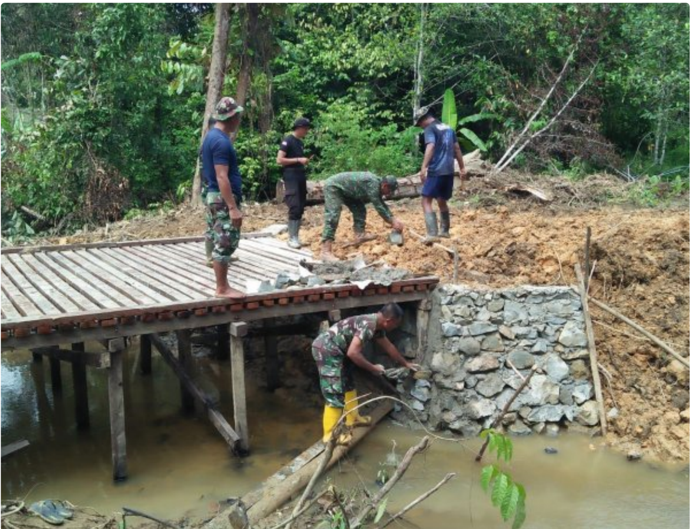
Progres Sasaran Jembatan Kayu Ulin TMMD Ke- 118 Wiltas Kodim/Malinau Capai 75 Persen
