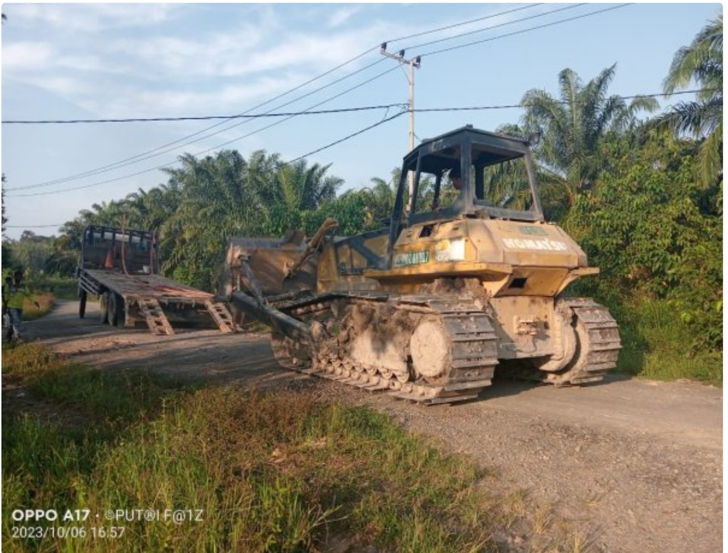
Percepat Pembukaan Badan Jalan Satgas TMMD Ke- 118 Turunkan Bulldozer
