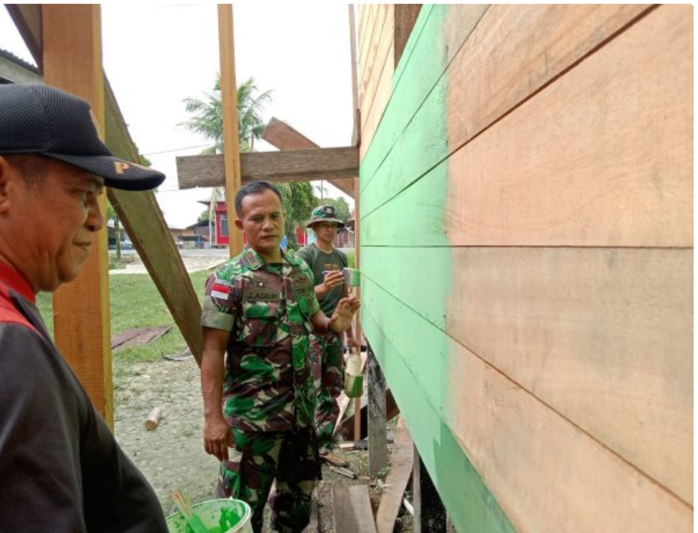
Pawas TMMD Ke- 118 Wiltas Kodim 0910/Malinau Cek Kualitas Rehab Tidak layak Huni
