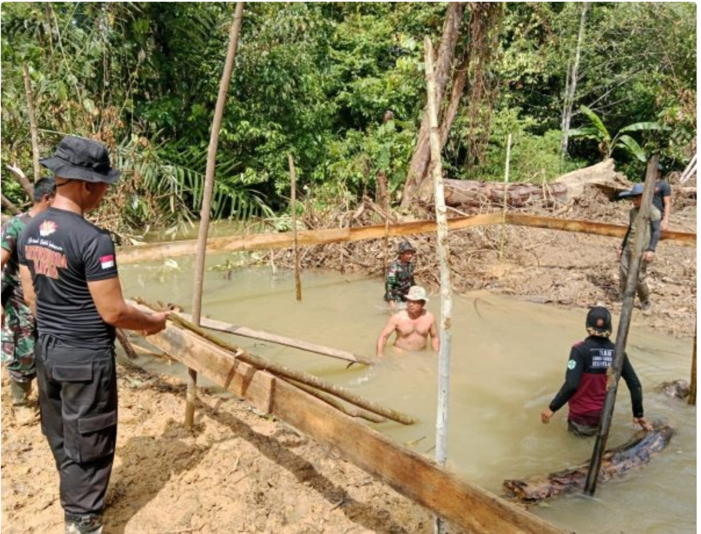
Jebur ke Sungai, Satgas TMMMD ke 118 Kodim 0910/Malinau Pasang Papan Mal Jembatan
