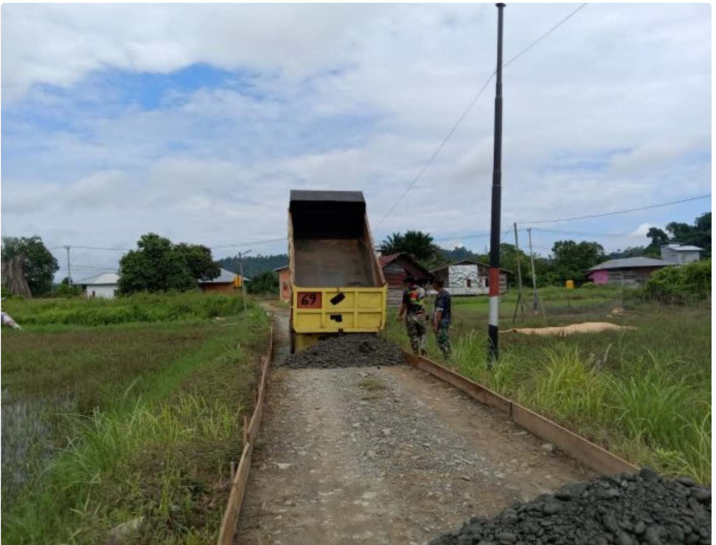
Dorongan Material Tanpa Putus, TMMD Ke- 118 Target Selesai Sebelum Penutupan
